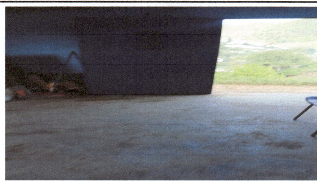
Foto 4: SUSTITUCIÓN DE PUERTAS, VENTANALES Y CAMBIO DE CUBIERTA DE PINTURA EN LAS PAREDES
