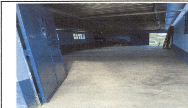
Foto 3: REPARACIÓN DE PARED Y PISO
