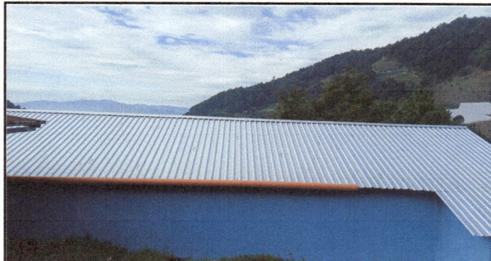
Foto 2: CAMBIO DE LÁMINAS A LÁMINAS TROQUELADAS
